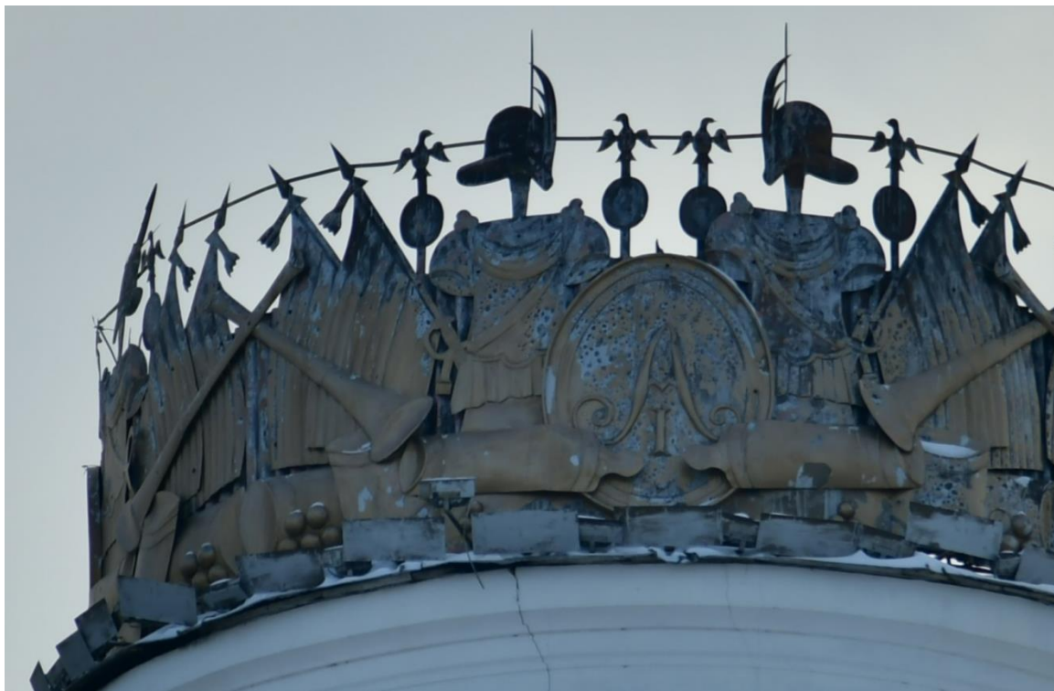
Рис. 6. Арматура заводской башни ГК. Весна 2024 г. Фото автора
