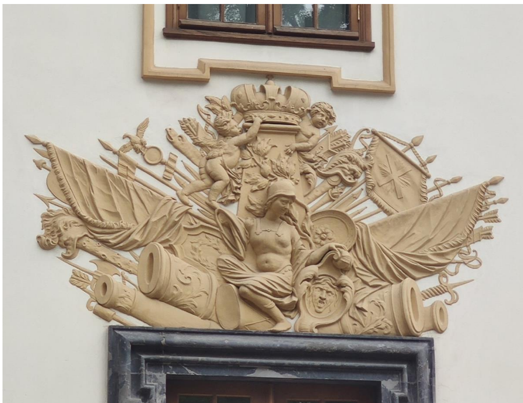
Рис. 1. Арматура над центральным входом в Летний дворец Петра I. Фото автора
